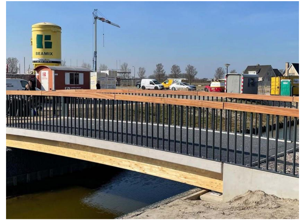
■ Innovatieve hout-betonbrug voor autoverkeer die de voordelen van hout (duurzaam) met die van beton (onderhoudsarm, lange levensduur) combineert. IPV Delft, bruggen Reimerswaal
