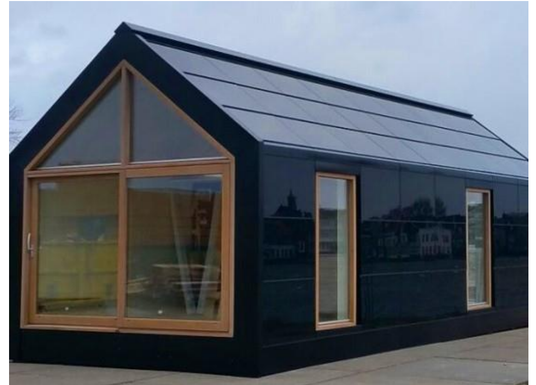
PV-panelen geïntegreerd in daken en gevels
