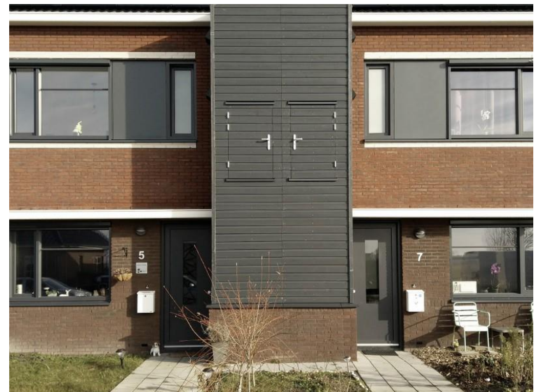
Warmtepomp geïntegreerd in de architectuur
