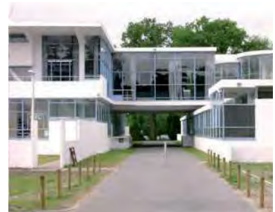
Sanatoriumgebouw met witgepleisterd betonskelet en slanke stalen kozijnen
