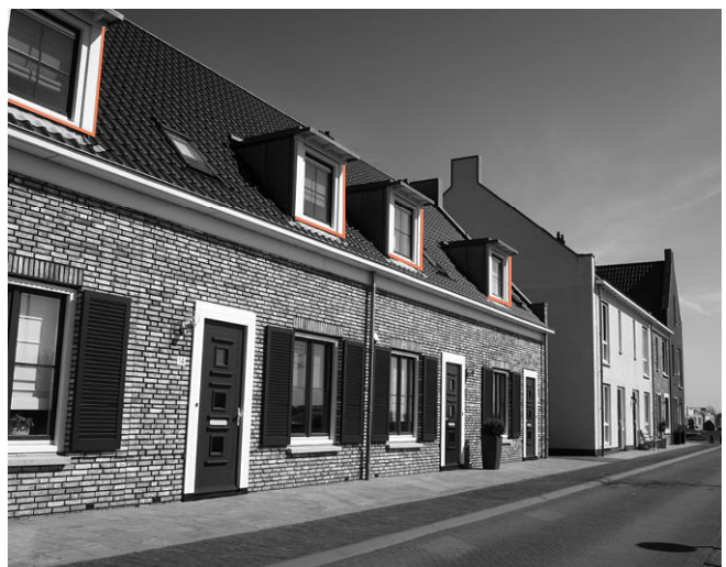
[afb. 04] Geplaatst op dezelfde horizontale lijn [afb. 05] Plaatsen binnen de verticale projectie van de noklijn
