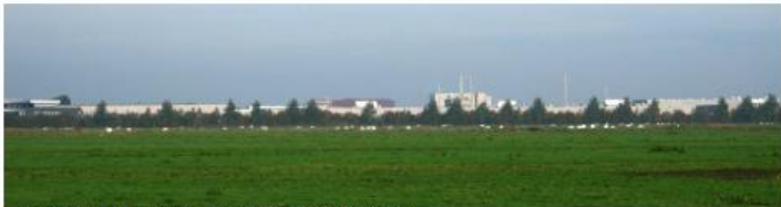
Fuite gezien vanaf de Nieuwe Weg, werkelijke situatie.
