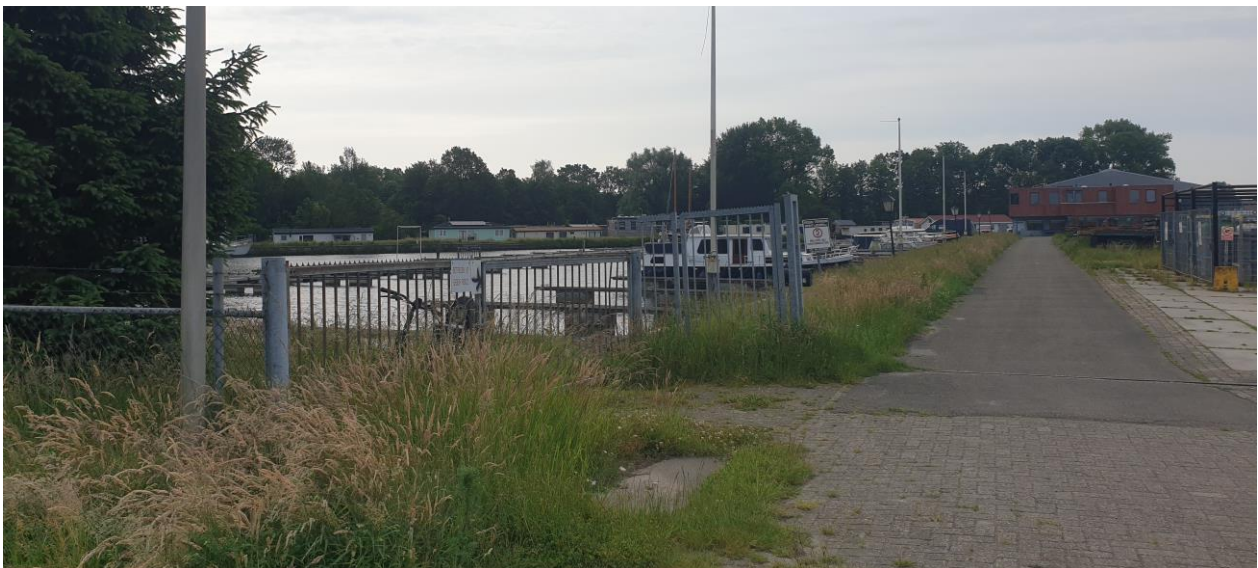
Figuur 1.4 De haven aan de noordzijde van het plangebied (deelgebied Steenwijkerstraatweg).
