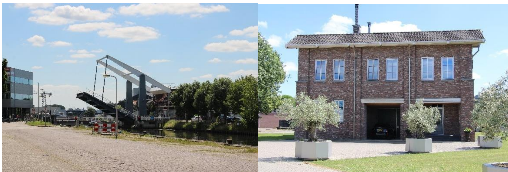
figuur 1: de Galgenkampbrug (links) en de onderzochte woning (rechts)
