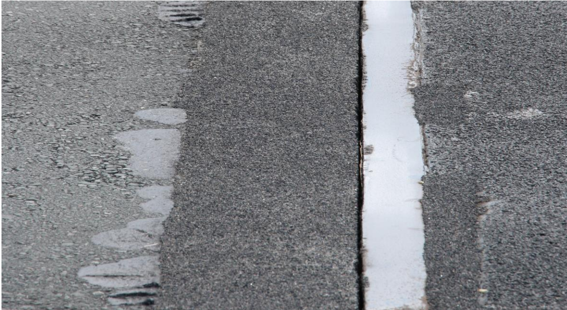
figuur 12: asfalt en de dilatatie op de huidige brug
