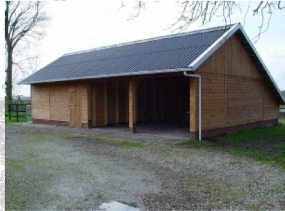
Voorbeeld kapschuur met stallen
