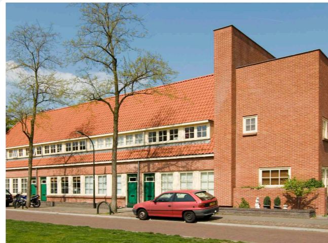
De gebouwen vormen een rustig daklandschap en een krachtig en sprekend silhouet. Dakkapellen zijn ondergeschikt en horizontaal uitgelijnd. (architect Braaksma & Roos)
