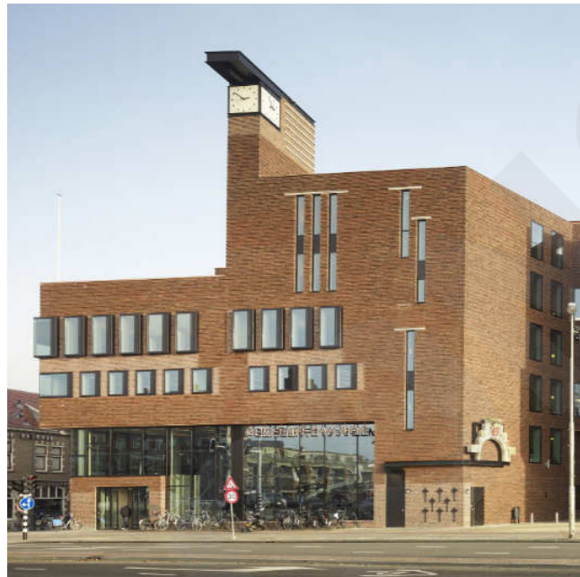
De publieksentree is duidelijk herkenbaar en de plastic geeft uitdrukking aan de verschillende functies in het gebouw. Architect: Bolles + Wilson
