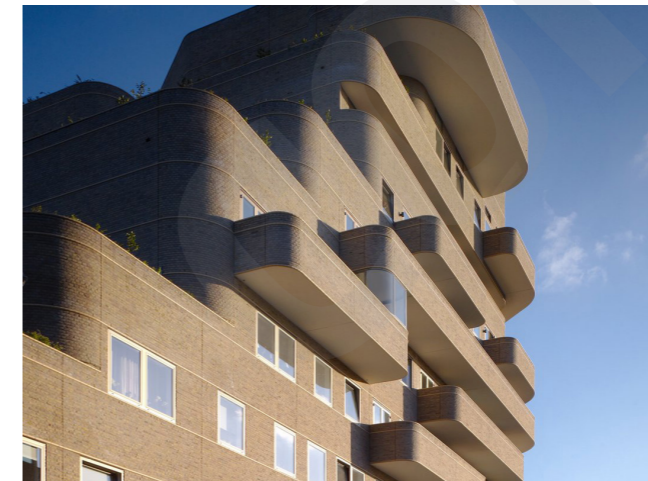
Balkons en erkers zijn integraal mee-ontworpen in de plastiek van het gebouw. Eekenhof, Enschede, architect Klaus en Kaan
