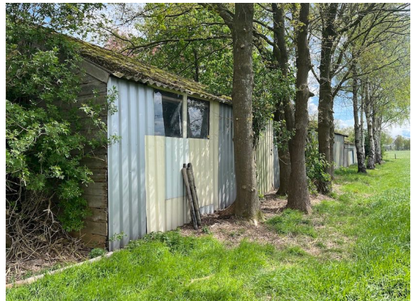
Figuur 5. Westgevel van het bijgebouw.
