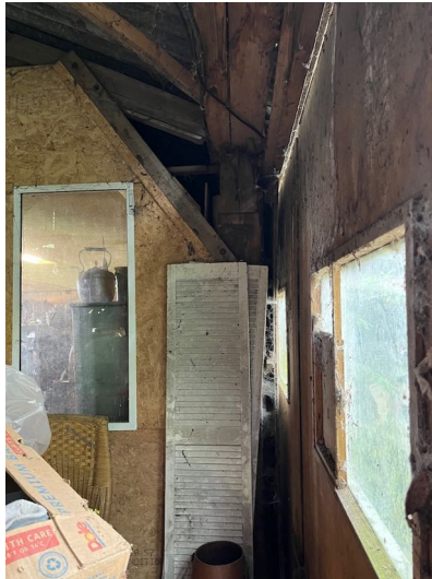
Figuur 9. Kamer in het bijgebouw met ruimte tussen de buitengevel (r) en de kamer (l).
