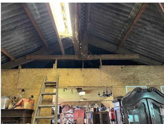
Figuur 6. Centrale deel van het bijgebouw met ingebouwde kamer.
