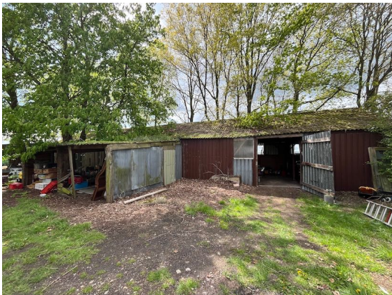
Figuur 4. Oostgevel van het bijgebouw.
