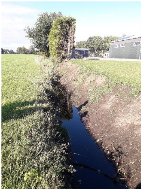
6 Hoogteverschil tussen weiland en perceel
