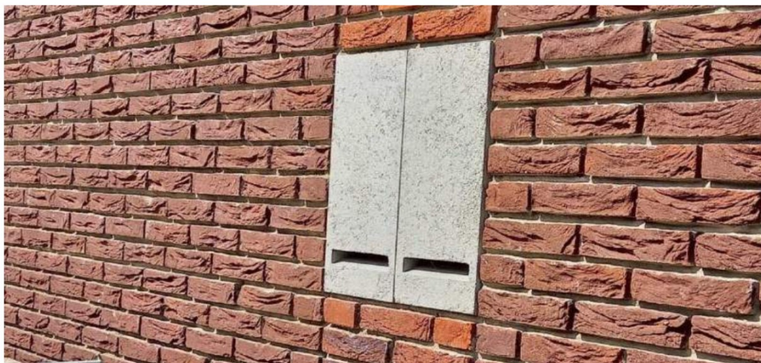
Figuur 6.2 Ingemetselde vleermuiskasten. Bron: Ecogroen.
