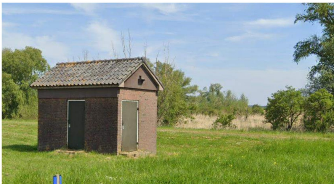
Figuur 6.9 Voorbeeld van een in een transformatorhuisje geïntegreerde steenuilkast. Achter de houten betimmering zijn ook voorzieningen voor vleermuizen aanwezig. Dergelijke voorzieningen zijn ook bij grotere gebouwen mogelijk. Ook nestkasten van andere vogelsoorten als kerkuil en torenvalk zijn een optie. Bron: Google Streetview.
