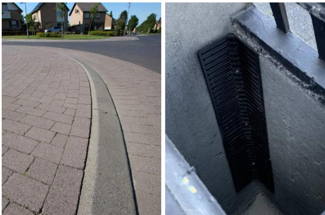
Figuur 6.13 Schuine trottoirband (links) Bron: MBI.nl en amfibietrap (rechts). Bron: Vivara.nl
