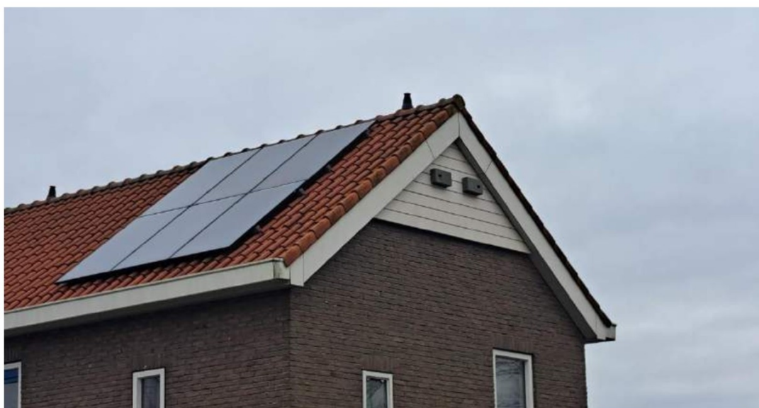
Figuur 6.3 Voorbeeld van gevelbetimmering voor vleermuizen. In de gevelbetimmering zijn ook nog gierzwaluwkasten verwerkt. De vleermuizen kunnen aan de onderkant van de gevelbetimmering invliegen.
