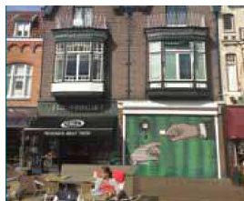
begane grondlaag rechts is geen geheel met pand
