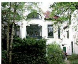
Karakteristieke elementen als ontlastingsbogen en roedeverdelingen
