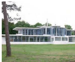
Samengesteld volume van het voormalige sanatoriumgebouw
