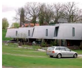
Gevels van de koker volledig bekleed met gevelpanelen
