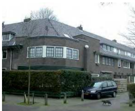
Horizontale geleding door gelijkde ramen
