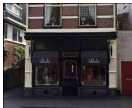
stem reclame af op gevelkarakteristiek
