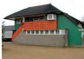
Houten directiegebouw met horizontale raambanden
