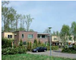
Geschakelde woningen bestaande uit samengestelde bakstenen blokken
