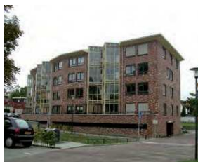
Blok gestapelde woningen met onderliggende parkeergarage
