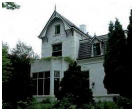
Gepleisterde gevels met decoratieve lijsten en gootklossen
