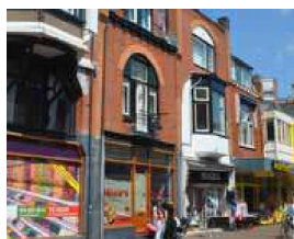
materiaal en kleurgebruik is onvoldoende afgestemd op hoofdvolume
