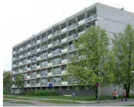
Herhaling in de gevel bij hoogbouw
