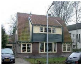
Gedifferentieerde gevel met nadrukkelijke gevelverlenging
