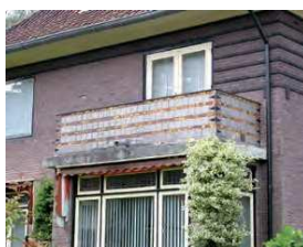
Uitgemetselde banden in gevel en betegelde borstwering zijn opvallend
