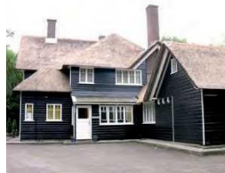
Pampahoeve met gedifferentieerde opbouw en samengestelde rietenkap
