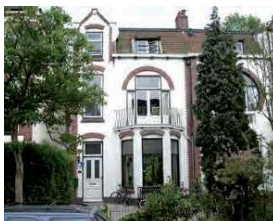
Gepleisterde gevel met bakstenen details
