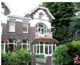
Bakstenengevel met sierpleisterwerk
