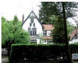
De statische hoofdvorm wordt verzacht door profileringen en deelsymmetrie
