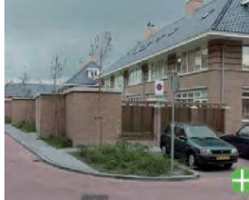
Goed geplaatst bijgebouw in passende vormgeving, materialen en kleuren
