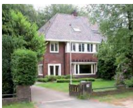
Erfafscheiding die bestaat uit een laag gemetseld muurtje met buisrailing
