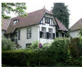
Gevels zijn voorzien van stijl- en regelwerk
