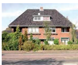
Dakkapel is ondergeschikt onderdeel in het dakvlak en symmetrisch geplaatst
