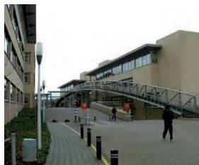
Brugconstructie bij het Nike-complex
