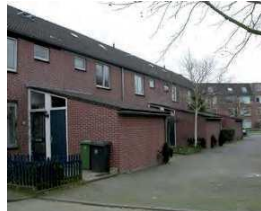
Aanbouwen aan de voorkant zorgen voor afwisseling in het beeld
