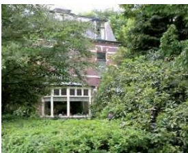
Gevels van baksteen met gepleisterde aanzetten, sluitstenen en speklagen
