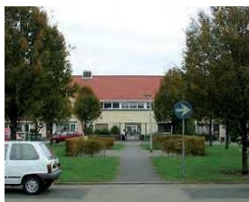
Samenhang tussen stedenbouw en architectuur door poort bij as
