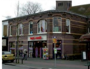
Fijne detaillering in de gevel, materialen en kleuren zijn in samenhang
