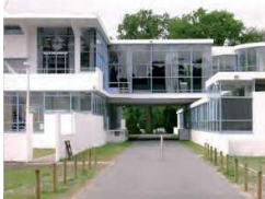
Sanatoriumgebouw met witgepleisterd betonskelet en slanke stalen kozijnen
