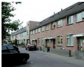
Nieuwbouw sluit in oriëntatie en ontsluiting aan op bestaande bebouwing
