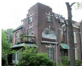
Bakstenengevels met siermetselwerkverbanden
