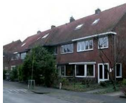
Seriematige woningen met ritmiek door wisselende dakvlakken en uitbouwen
