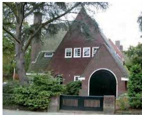
Mee ontworpen aanbouw
