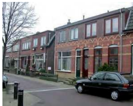
Fijne detaillering in het metselwerk
