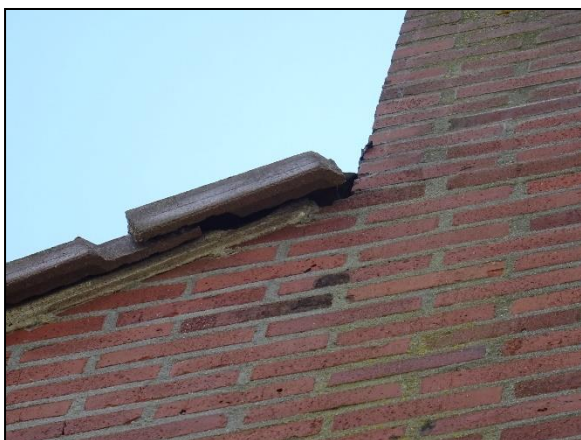
Figuur 11. Close up ruimte onder kantpannen, geschikt voor gierzwaluw en vleermuizen.
