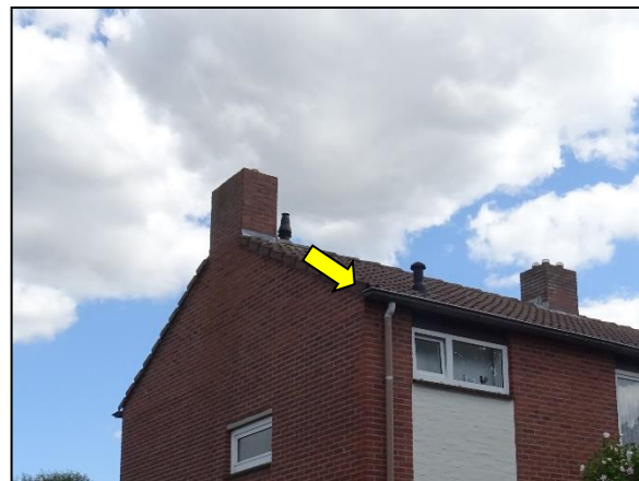
Figuur 10. Voorbeeld van ruimte tussen dakgoot en dakpannen, geschikt voor huismus.
