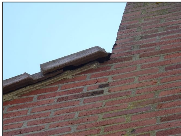
Figuur 14. Ruimtes tussen dakpannen verlenen toegang tot de ruimte onder de dakpannen.
