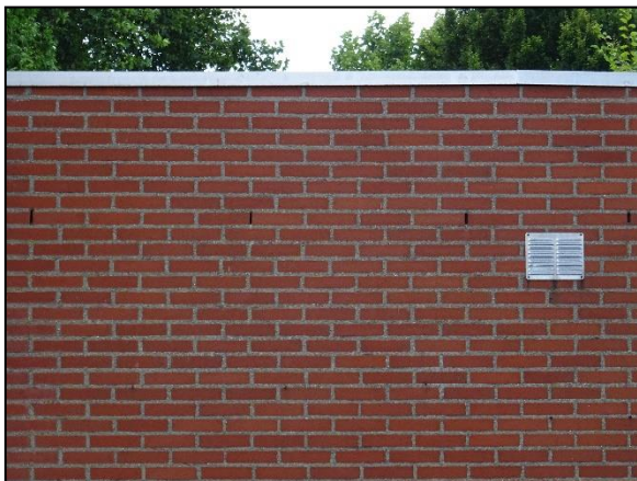
Figuur 13. Stootvoegen in het gebouw verlenen toegang tot de spouw.
