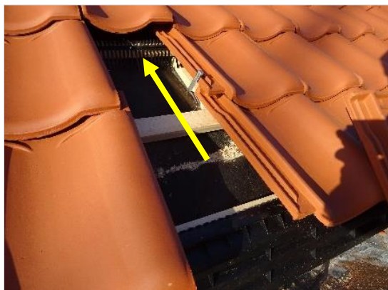
Figuur 3-7 Voorbeeld plaatsen vogelschroot bij derde rij dakpannen.
