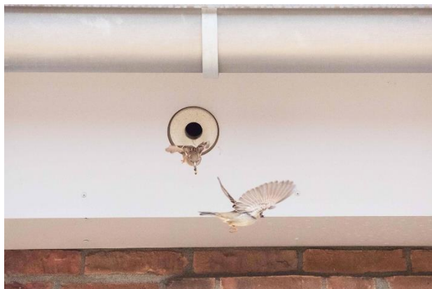
Figuur 3-9 Inbouw nestkast type HMP3 ingebouwd in gootbetimmering (bron: Unitura).
