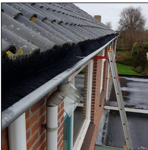
Figuur 3-3 Voorbeeld van aangebrachte weringborstels (bron: Unitura).
