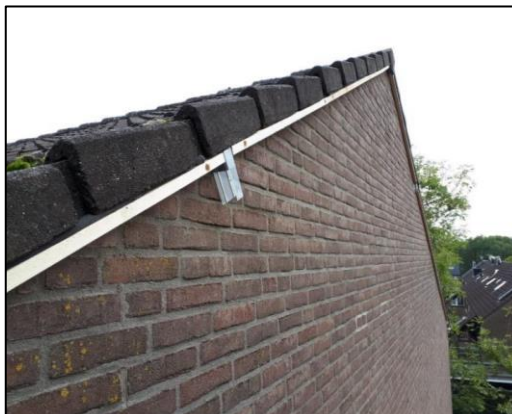
Figuur 3-6 Spleetvormige ruimte onder kantpannen afgedicht met latten en exclusion flaps.
