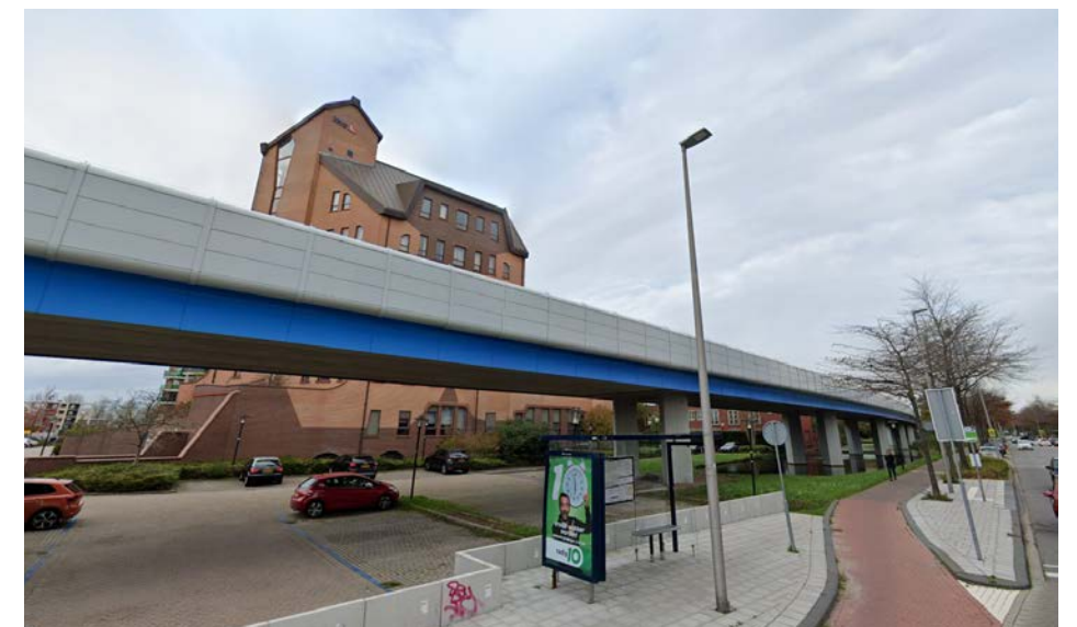
Gebouw vanaf de Duikerlaan
