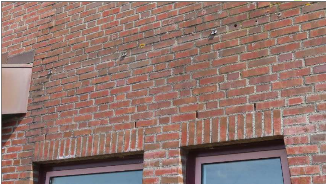
Stootvoegen in de gevel van het kantoorpand die toegang bieden tot de spouwmuur. Foto: [REDACTED] | Ecoresult B.V.
