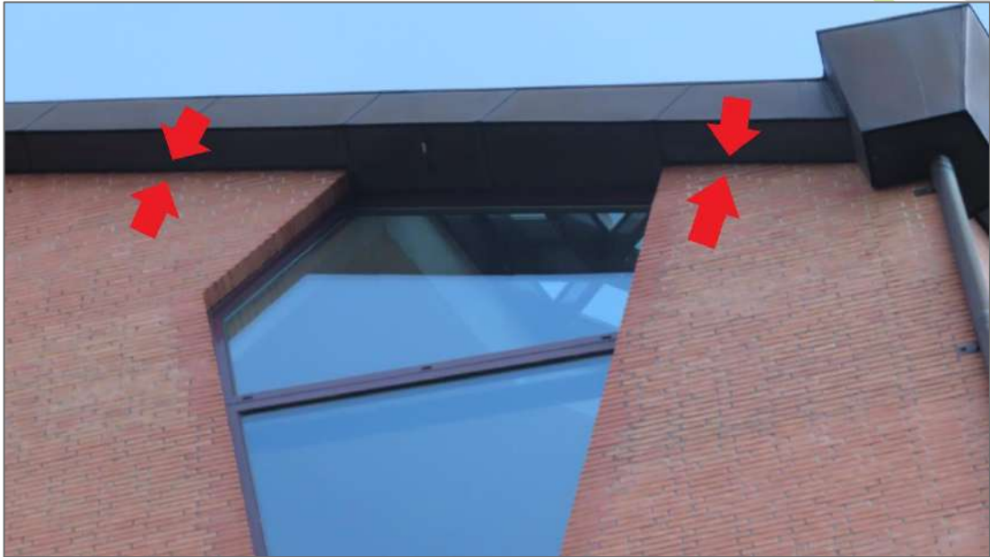
Figuur 12: Ruimte tussen gevels en dakgootbekisting. Foto: [REDACTED] | Ecoresult B.V.
