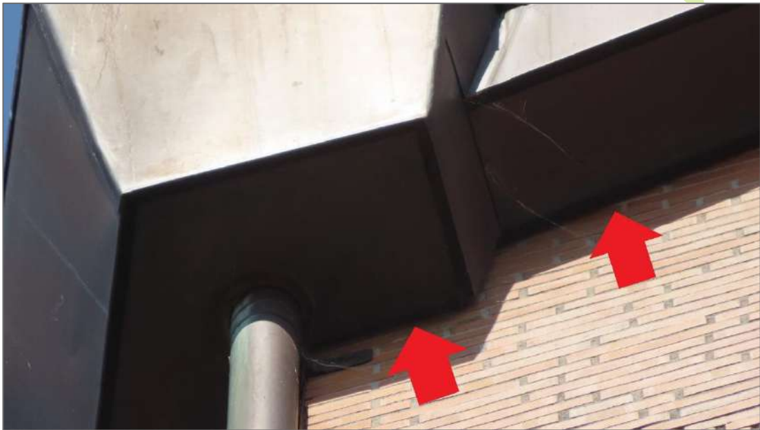
Ruimte tussen gevel en dakgootbekisting Foto: [redacted] | Ecoresult B.V.
