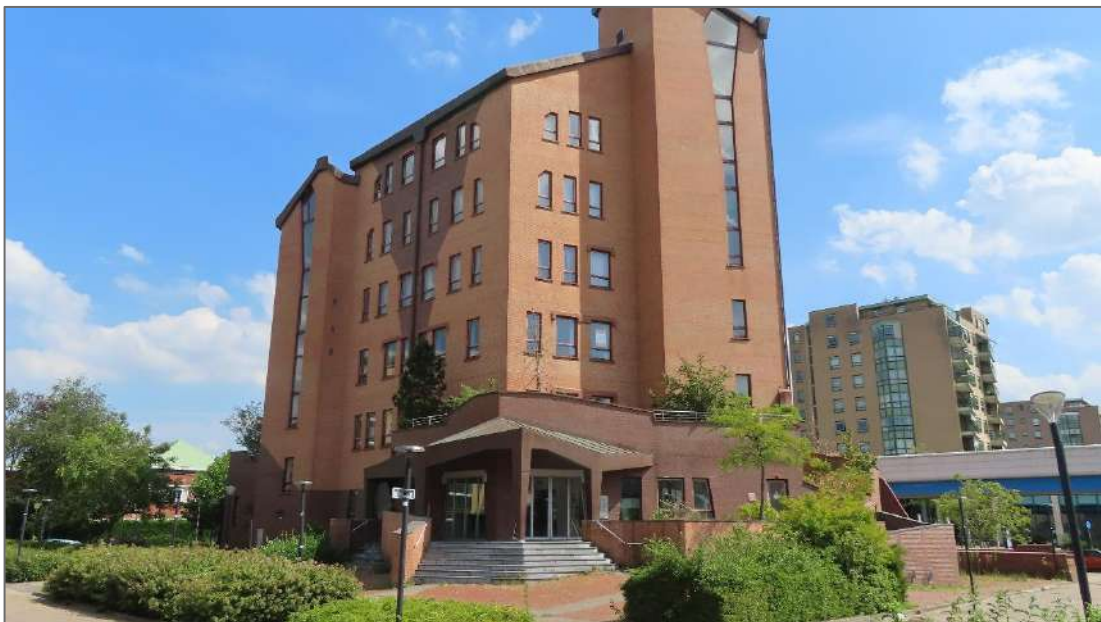
Figuur 3: Hoofdingang kantoorpand vanaf het westen gezien. Foto: [REDACTED] | Ecoresult B.V.
