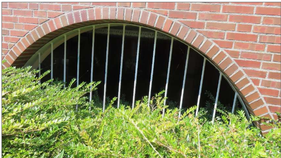
Figuur 13: opening in gevel die toegang biedt tot de ondergrondse garage. Foto: [REDACTED] | 05-08-2024 | Ecoresult B.V.
