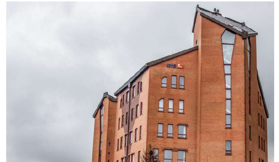
Gebouw vanaf de Kerklaan
