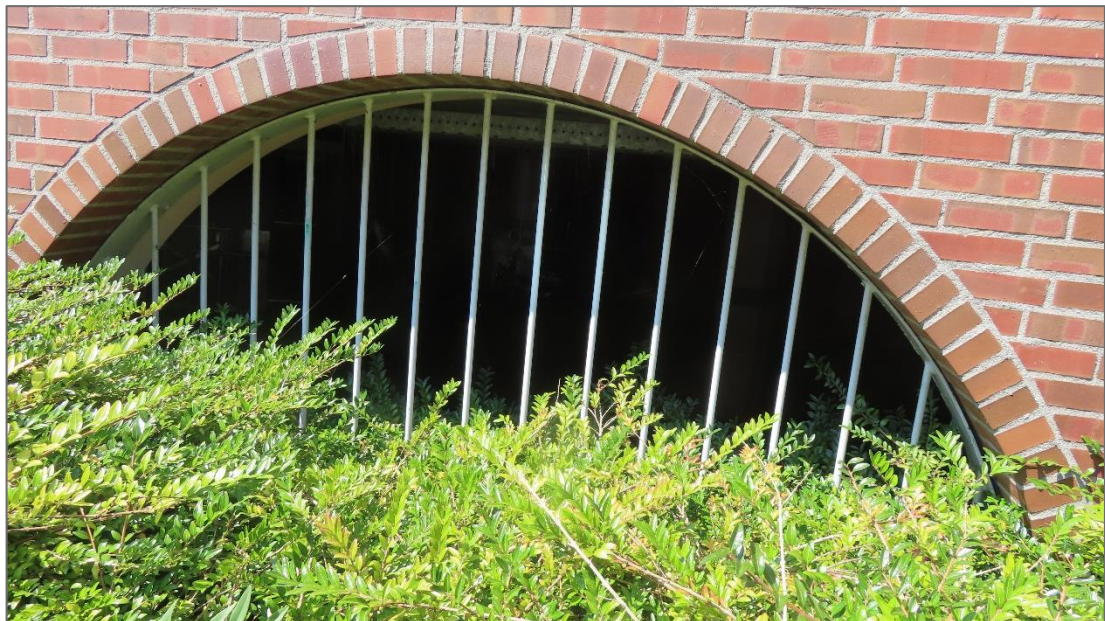
Figuur 13: opening in gevel die toegang biedt tot de ondergrondse garage. Foto: [REDACTED] | 05-08-2024 | Ecoresult B.V.
