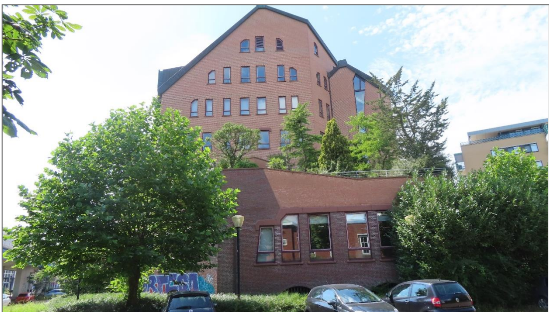
Noordoostelijke gevel kantoorpand met bomen en struikbegroeiing. Foto: [REDACTED] | Ecoresult B.V.
