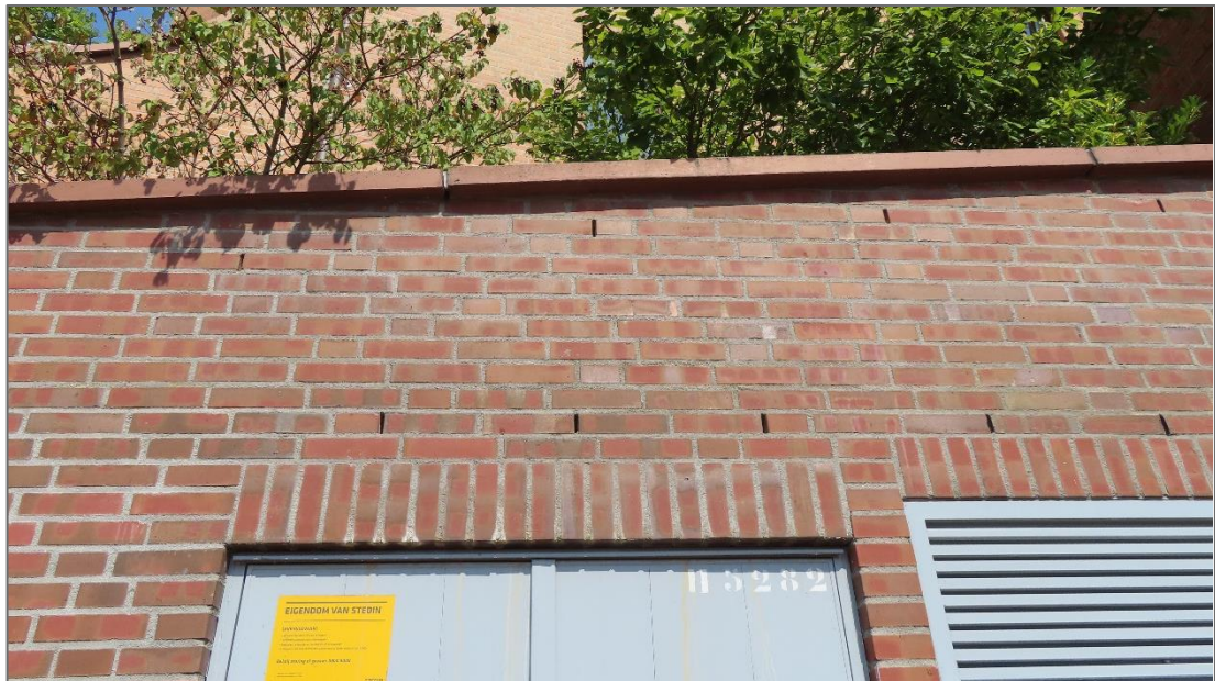
Figuur 11: Stootvoegen in het kantoorpand die toegang bieden tot de spouw. Foto: [REDACTED] | Ecoresult B.V.
