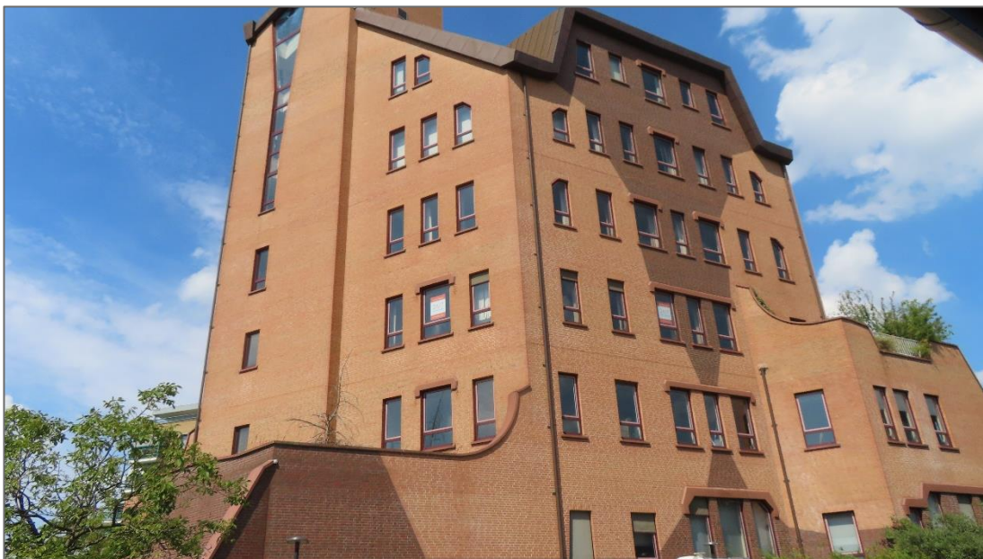
Zuidwestelijke gevel kantoorpand. Foto: [REDACTED] | Ecoresult B.V.
