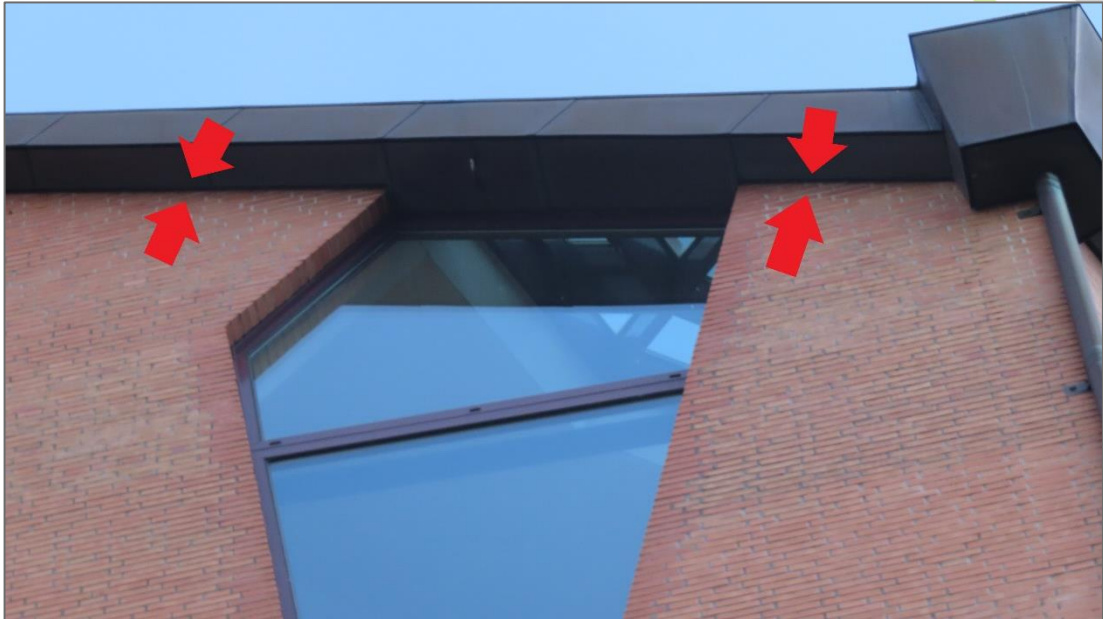
Figuur 12: Ruimte tussen gevels en dakgootbekisting. Foto: [REDACTED] | Ecoresult B.V.
