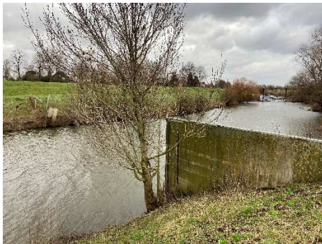
Figuur 13: asbestcementplaten in het koelwaterkanaal
