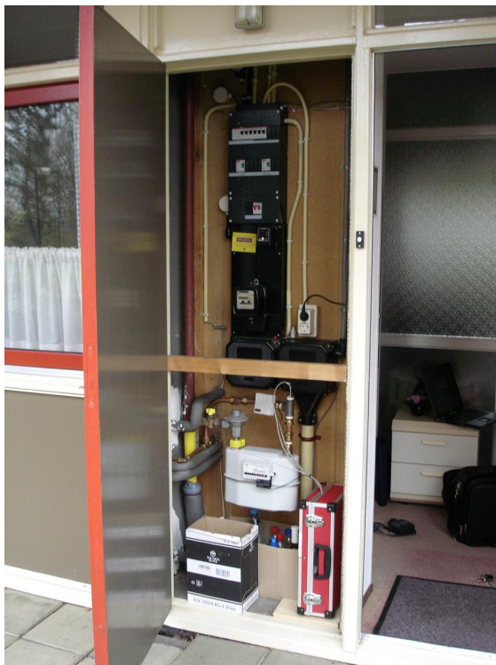
Figuur 3: Meterkast op de galerij
